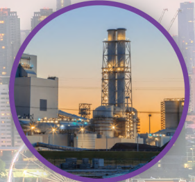
โรงไฟฟ้า
