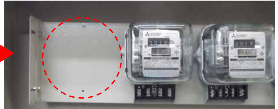
ถอดมิเตอร์จานหมุนเดิมออก
